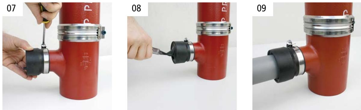
**Рис. 08** Внимание! Удаляйте резиновые заглушки только с помощью тупого инструмента, например, щипцов и ни в коем случае не при помощи ножа, так как в противном случае резиновый уплотнитель может быть поврежден.
